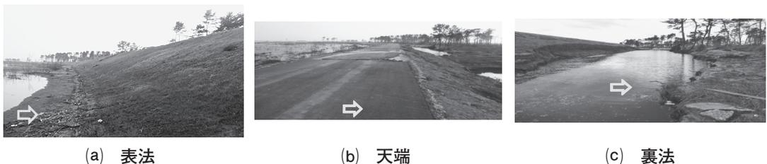
写真-1 津波後（4/30）の盛土の状況：矢印は押し波の方向
