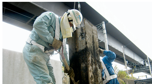
付着土撤去状況
