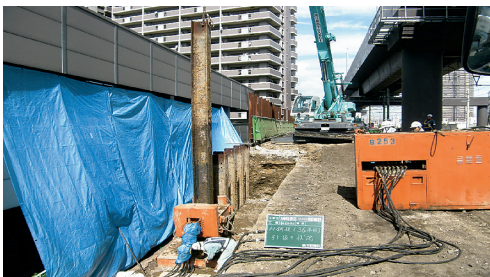
パイルプラー及び引抜き状況
