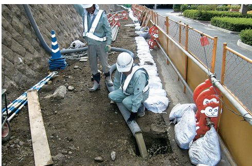
流動化処理土流入状況
