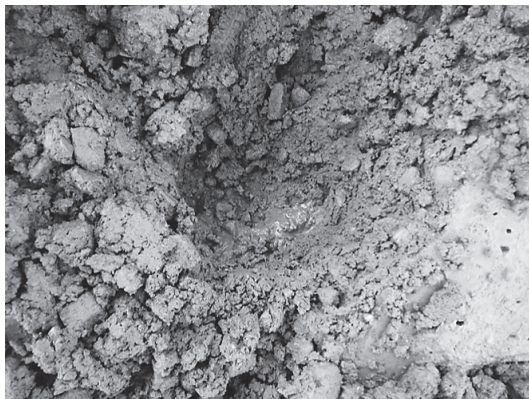
写真-10 壁面Aコンクリート
