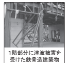
1階部分に津波被害を受けた鉄骨造建築物
