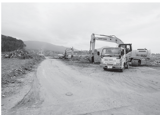
写真 がれきの処理状況 (平成23年9月、陸前高田市)
