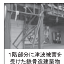
1階部分に津波被害を受けた鉄骨造建築物
