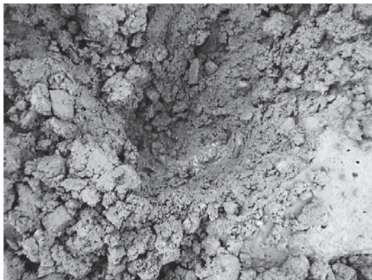
写真-10 壁面Aコンクリート
