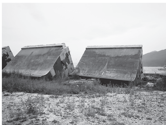
6 山田町舟越地区 堤防
