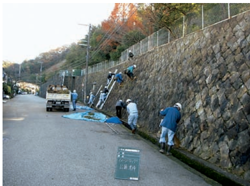
現場付近清掃
