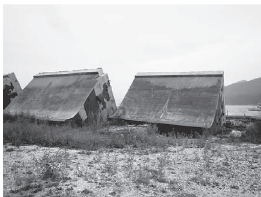
6 山田町舟越地区 堤防
