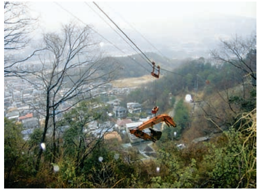
着工前現場付近
