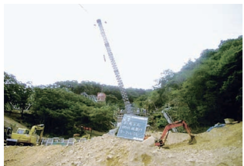
起伏装置付きケーブルクレーン
