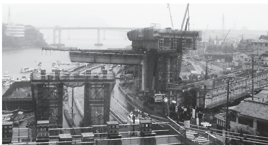
図-9 旋回横取り施工前
