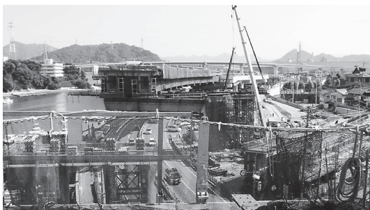
図-10 旋回横取り施工完了
