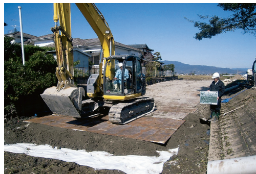
試験施工状況写真
