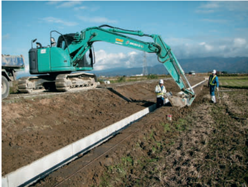
図－１ 対策前施工状況
