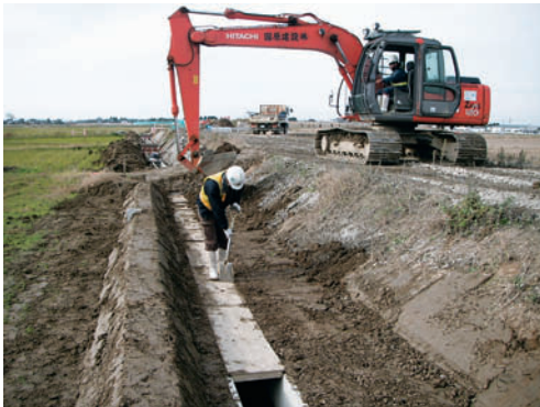
図－３ 合板足場板を使用した作業状況
