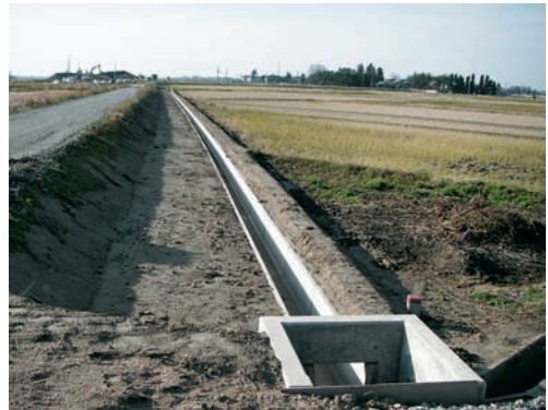
図－４ 畦畔仕上げ完了
