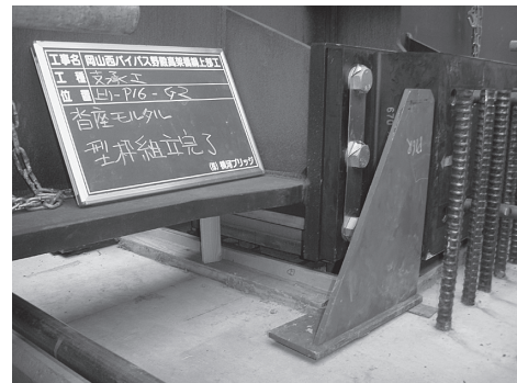
写真－4 バッファ固定金具取付位置
