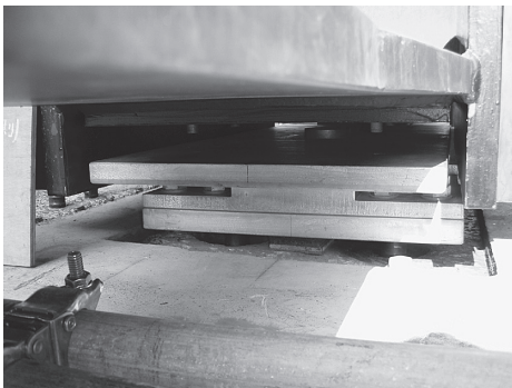
写真-6 水平沓ソールプレートと下沓の干渉
