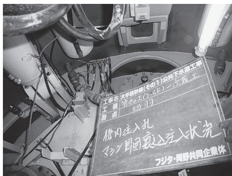
写真-1 機内注入状況
