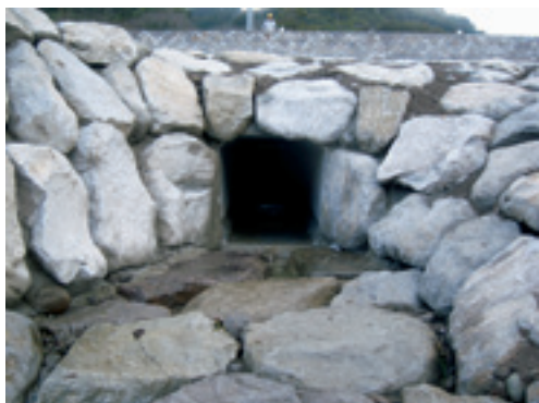
図－５ 樋管流末部の端部処理状況
