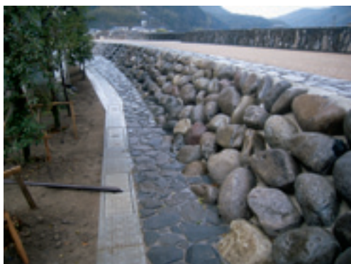
図－１ 川裏玉石積み状況
