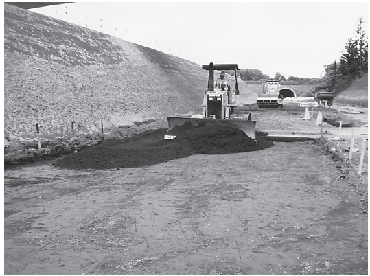
写真-1 現場施工状況
