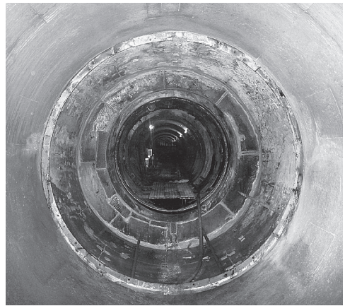
写真-6 シールド接続完了
