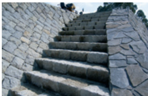
図－３ 階段部の施工状況
