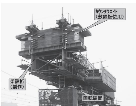
写真-2 設備組立完了 (回転前)
