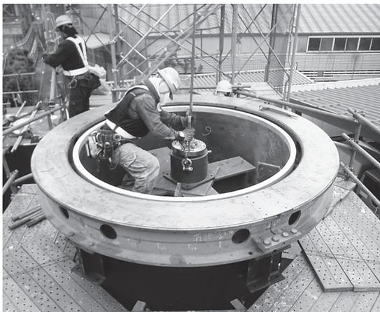
写真-4 柱内部（ピボット沓仮設置状況）
