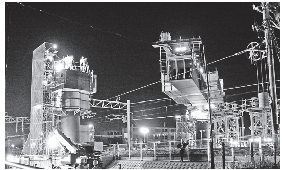
写真-3 回転架設状況
