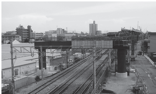
写真-1 (下部工) 完成状況
