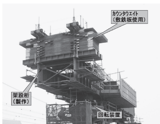
写真-2 設備組立完了（回転前）
