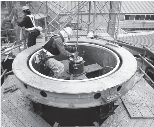
写真-4 柱内部（ピボット沓仮設置状況）
