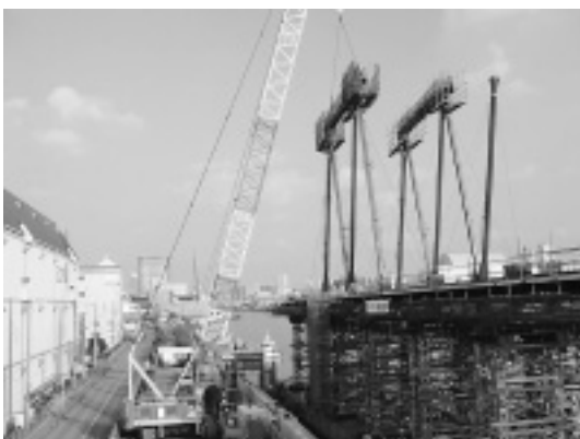
写真-3 桁(アーチ)組立状況
