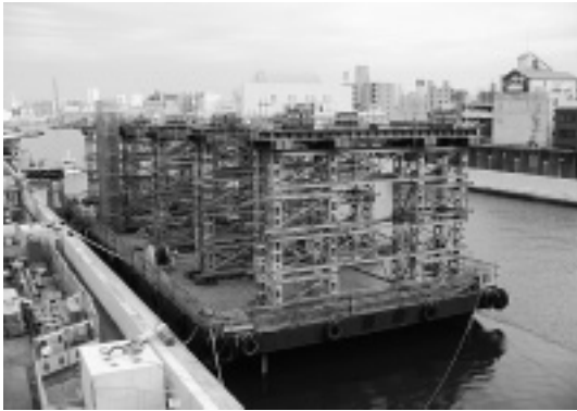
写真-2 ベント設置状況
