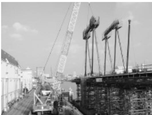
写真-3 桁(アーチ)組立状況
