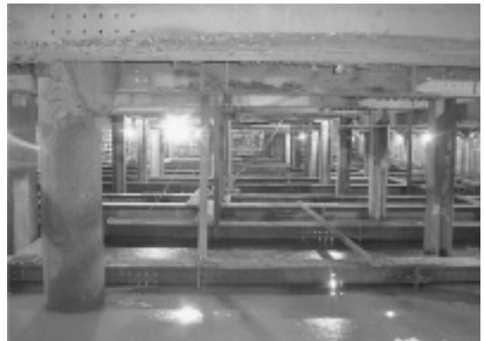
写真-2 掘削部の状況
