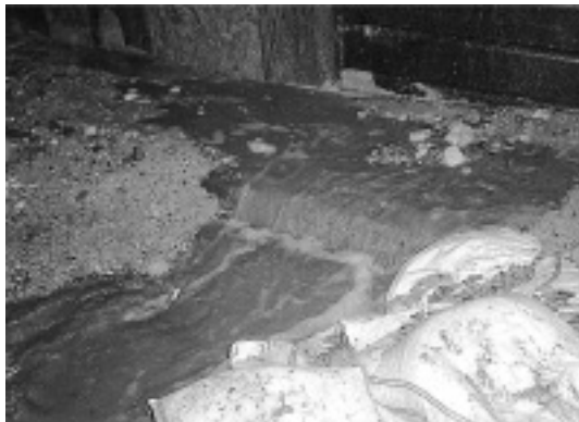
写真-1 欠損部の状況
