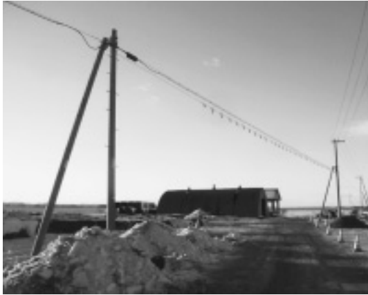
写真-2 三角旗取付け完了
