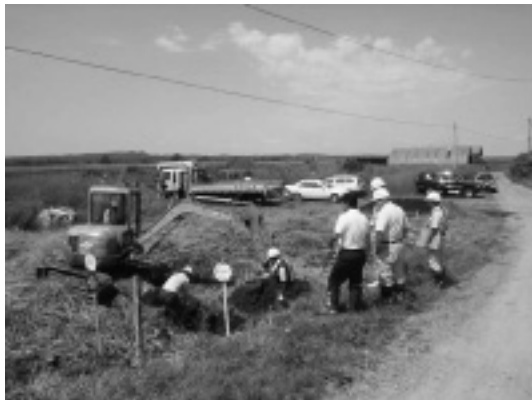
写真-3 水道管試掘状況
