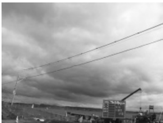
写真-1 防護管取付け完了
