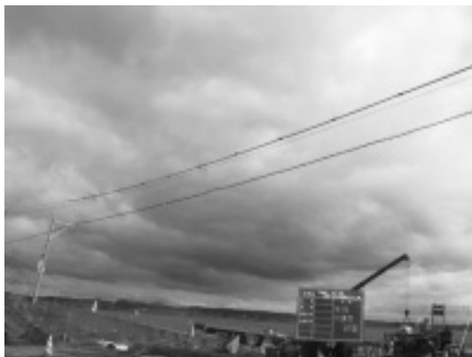
写真-1 防護管取付け完了
