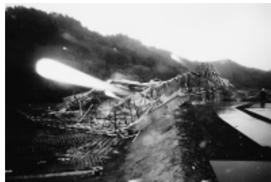
写真-2 雪寒仮囲散乱状況
