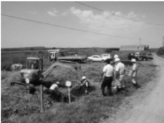
写真-3 水道管試掘状況
