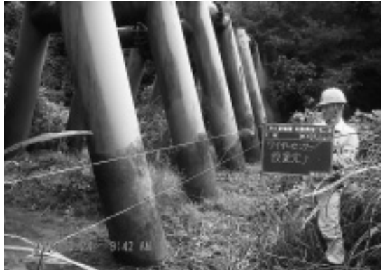
写真-2 ワイヤセンサー設置
