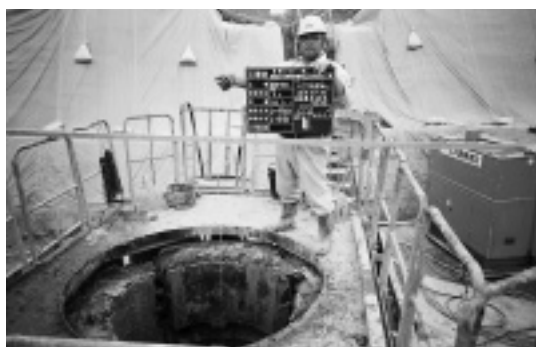
写真-3 鉄筋かご高測定状況
