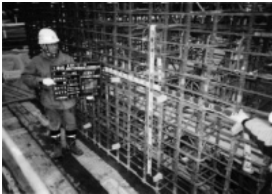
写真－6 配筋寸法確認
