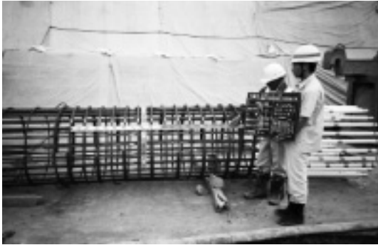
写真－5 施工検査状況
