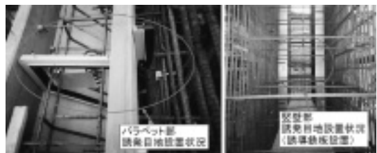
写真-4 誘発目地設置状況
