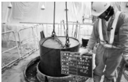
写真-2 スライム処理状況
