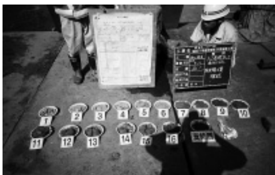
写真-1 土質確認状況
