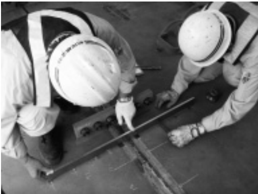
写真－2 角変形計測
