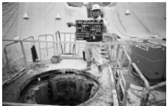
写真－3 鉄筋かご高測定状況
