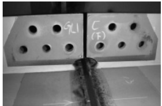
写真－3 溶接完了後摩擦接合面
