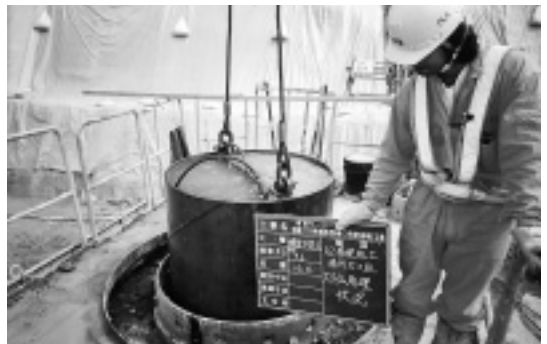
写真－2 スライム処理状況
