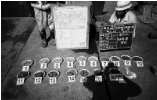
写真－1 土質確認状況
