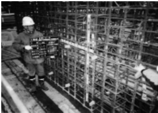
写真－６ 配筋寸法確認
