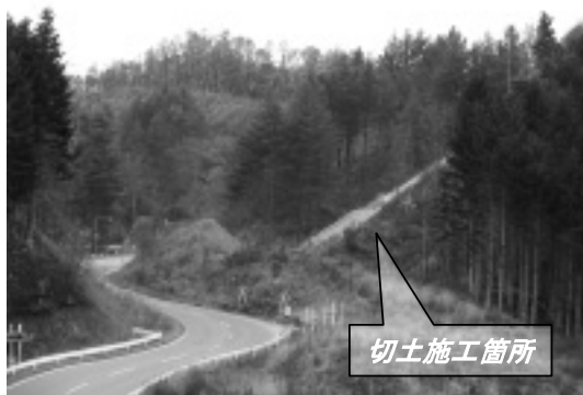
写真-1 切土施工箇所（工事着工前）
