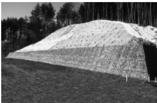
写真-2 鋼製組立枠
