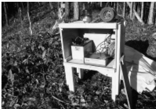
写真-4 地すべり警報装置
