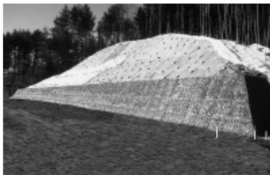
写真-2 鋼製組立枠
