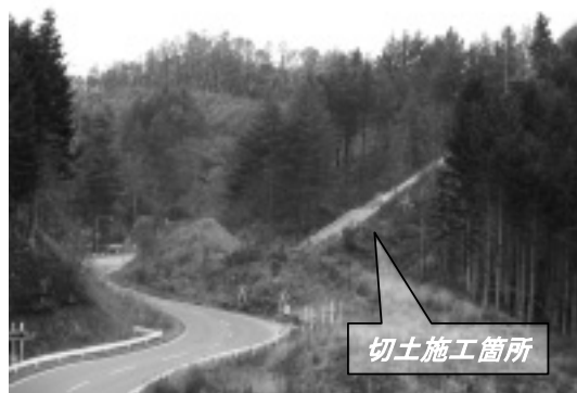
写真-1 切土施工箇所（工事着工前）
