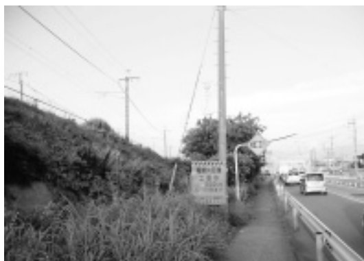
写真-1 施工箇所写真
