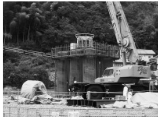
写真-1 橋脚全景
