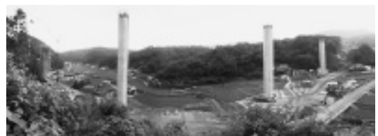
写真-2 橋脚全景
