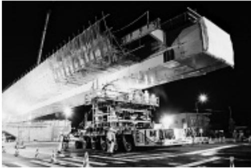
写真-1 大型搬送車による送り出し
