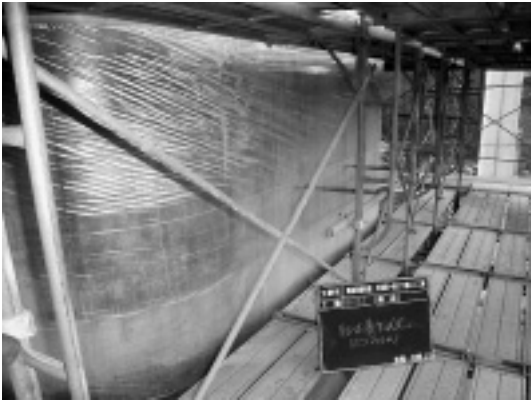
写真-5 ビニールシート養生（脱型後）
