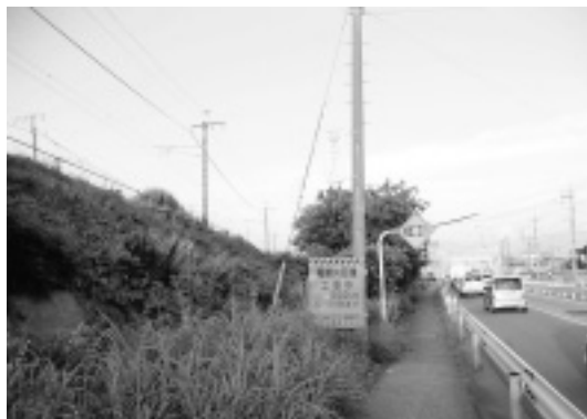
写真-1 施工箇所写真
