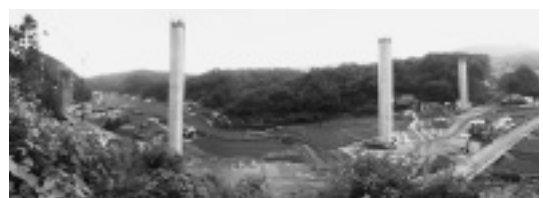
写真-2 橋脚全景
