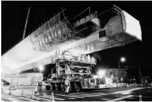
写真-1 大型搬送車による送り出し
