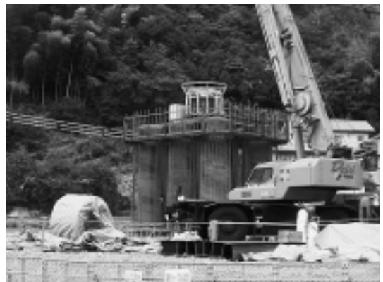
写真-1 橋脚全景
