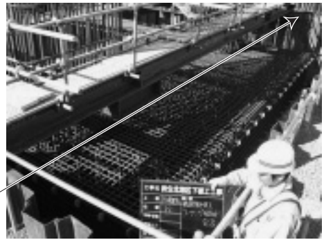
写真-4 改善鉄筋足場による鉄筋組立完了状況
