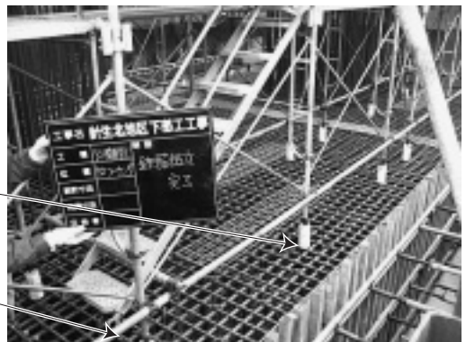
写真-1 従来の鉄筋足場の施工状況写真
