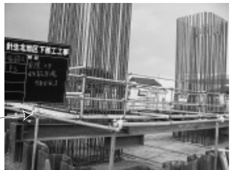
写真-5 改善鉄筋足場による鉄筋組立施工状況
