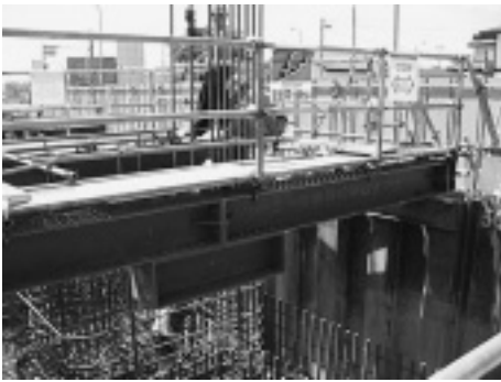
写真-2 改善鉄筋足場による鉄筋組立施工状況
