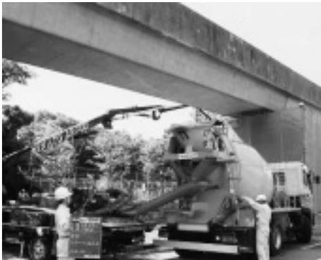
写真-11 梁部への打込み状況
