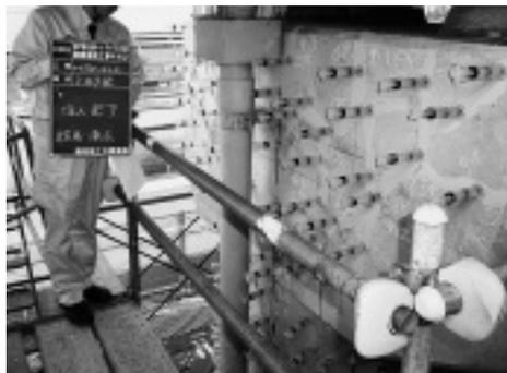
写真-7 柱部へのひび割れ注入状況 1
