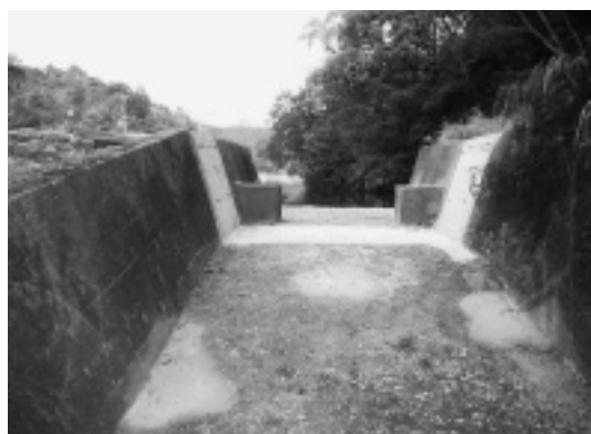
写真-3 補修後の敷張コンクリート
