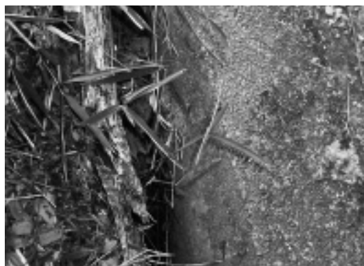
写真-2 腐った根
