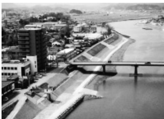
写真一九 施工完了後
