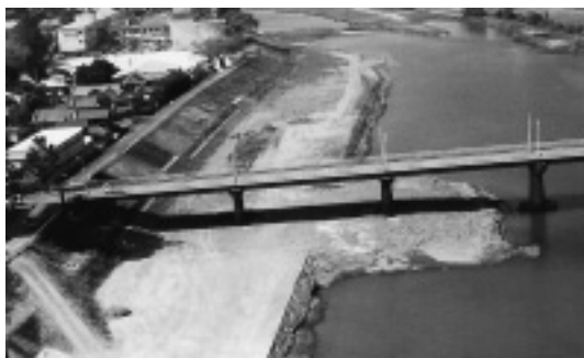
写真一八 着手前状況
