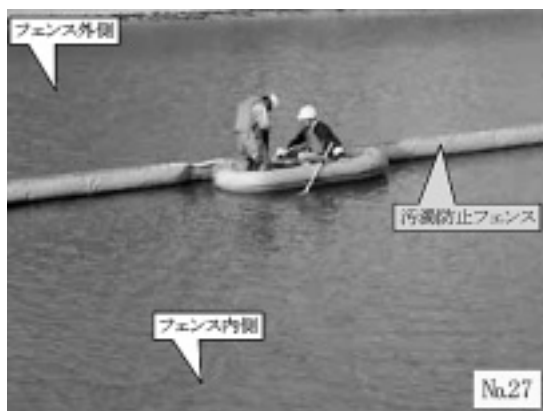
写真一七 異常発生時の水質調査状況
