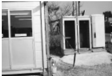
写真-13 水洗便所、土間コン設置
