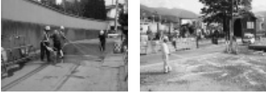
写真-9 道路水洗い、土場に塩カリ撒き・散水
