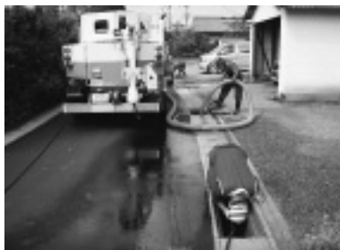
写真-14 側溝の掃除
