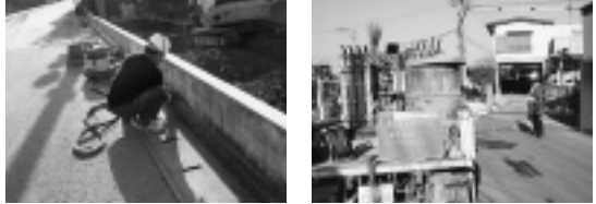
写真-12 カッター切断時の吸収機の使用と汚泥処理機の使用
