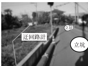
写真-2 生活道路確保の迂回路用地
