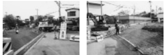
写真-7 仮設道路
