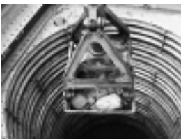
写真-3 立坑掘削
