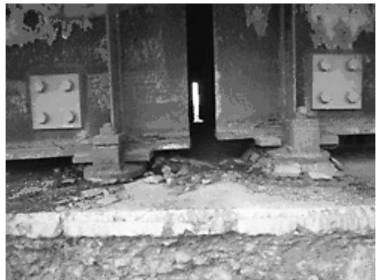
写真一 支承の台座コンクリートの破損
