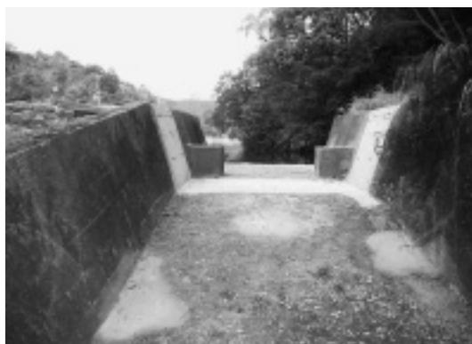
写真-3 補修後の敷張コンクリート
