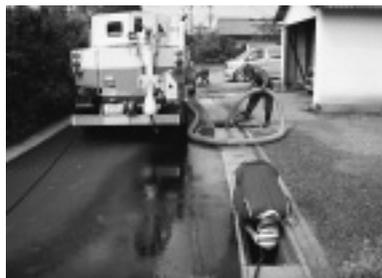
写真-14 側溝の掃除
