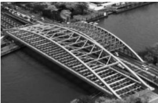
写真-1 架設完了時の全景
