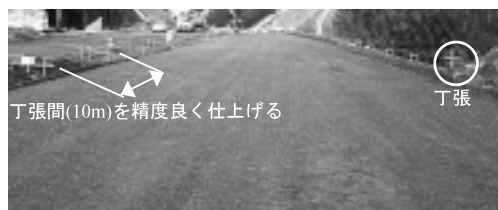
写真-1 丁張間の仕上げ
