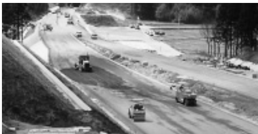
写真－2 上層路盤施工状況
