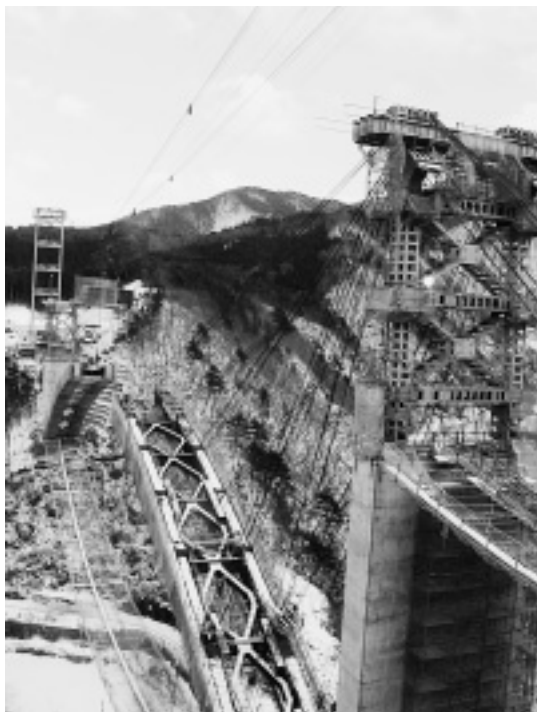
写真-1 厳冬の斜吊架設（平成18年2月）
