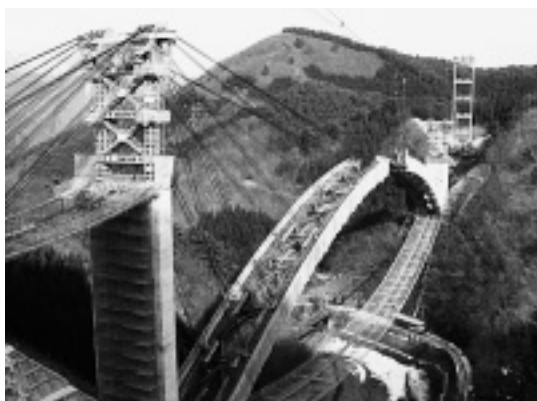
写真-2 アーチリブ斜吊架設（多点吊方式）
