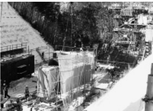
写真-6 ジョイント部養生状況
