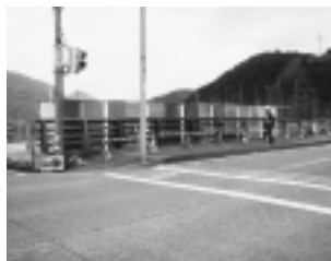
写真-2 落下防止柵内側
