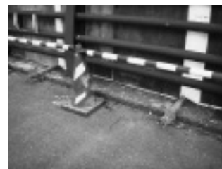
写真-3 落下防止柵内側下部
