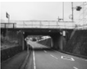
写真-1 交差道路より落下防止柵外側
