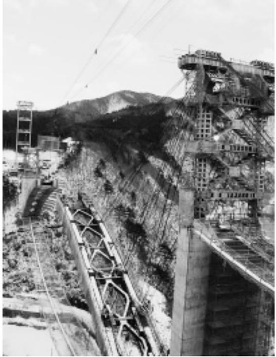
写真-1 厳冬の斜吊架設（平成18年2月）
