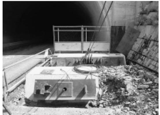
写真-4 A1ケーブルクレーンアンカー
