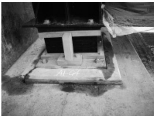
写真-2 補修完了
