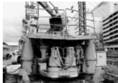
写真-1 ケーシング内土砂の投入状況
