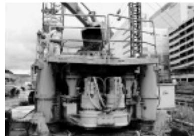
写真-1 ケーシング内土砂の投入状況
