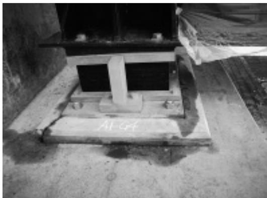
写真-1 沓モルタルのひび割れ状況
