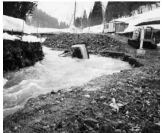
写真-1 被災状況
