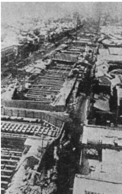
写真-1 戦前の開削工事（大阪地下鉄）
