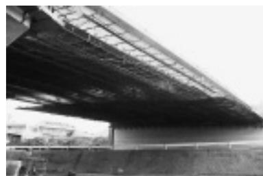
写真-3 吊り足場設置完了
