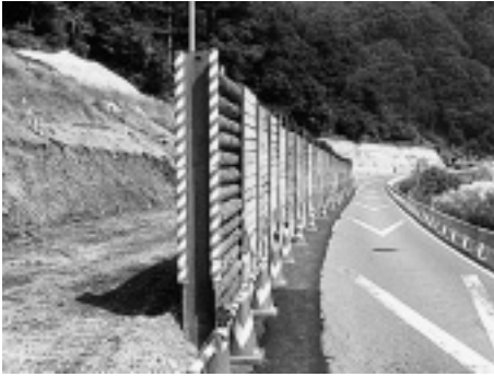
写真-2 仮設防護柵及び安全対策
