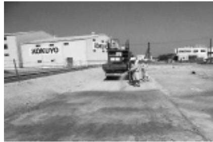
写真-5 飛砂・粉塵防止剤の散布
