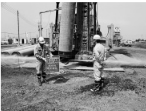
写真-2 STJビット高圧ポンプ噴射状況
