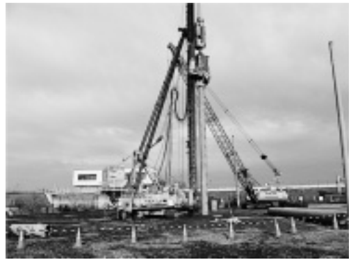
写真-3 STJ工法 杭圧入状況
